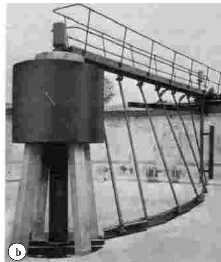
Fig. 7: Particolare della vasca di sedimentazione di fig. 5 a) Ponte raschiatore con ruote gommate di trascinamento. b) Raschiatore di fondo con raschietti disposti in forma elicoidale.
