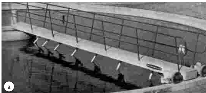
Fig. 7: Particolare della vasca di sedimentazione di fig. 5 a) Ponte raschiatore con ruote gommate di trascinamento. b) Raschiatore di fondo con raschietti disposti in forma elicoidale.
